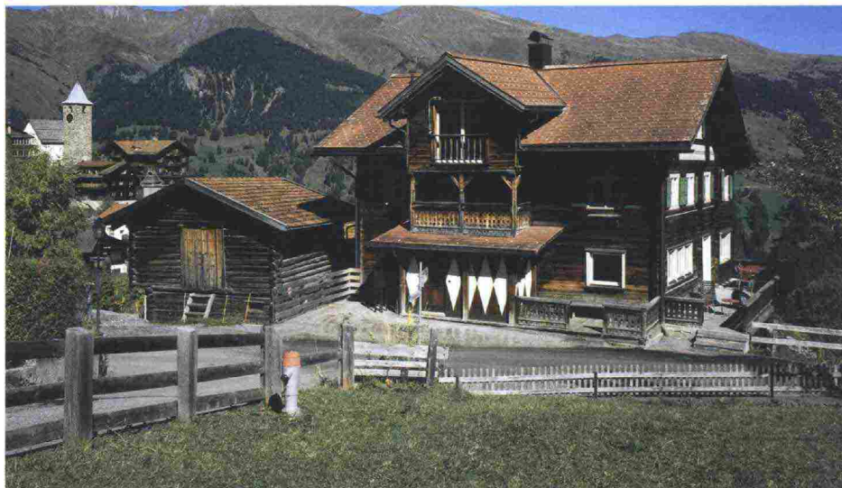
Sopra: situata nel Cantone dei Grigioni, la casa di fine Ottocento dalla solida struttura in legno secondo la tradizione costruttiva locale ospitava in origine un ristorante con una piccola pensione. A destra: il corridoio d'ingresso che porta alla sala a doppia altezza per occasionali esposizioni e concerti (pagina a fronte) aperti al pubblico
